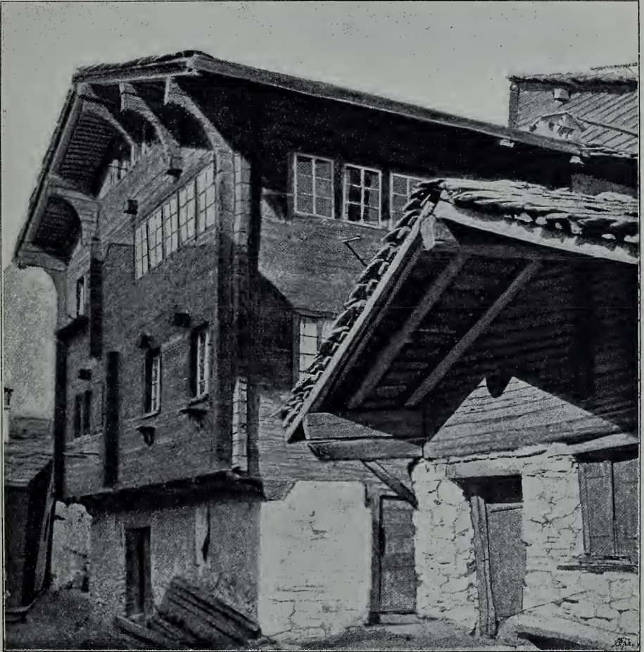
Fig. 116. Häuserpartie aus Stalden.
